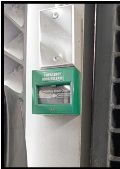
Foto 1: Botón de Emergencia Sistema de Puertas Automáticas Deslizantes.
